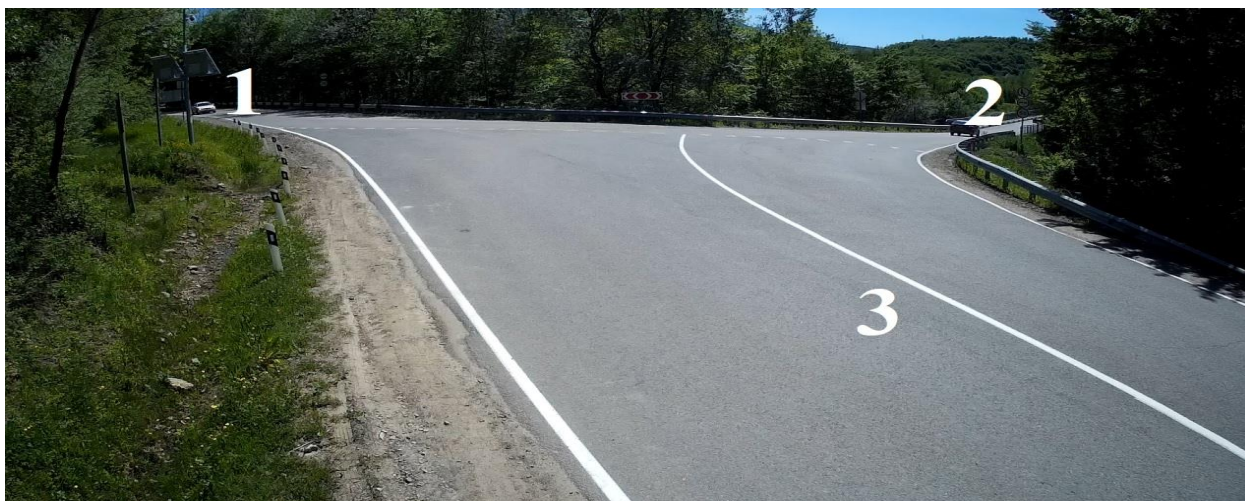
Рисунок Г.3.2 – Фото перекрестка а/д 03 ОП МЗ 03Н-518 «с. Шаумян - х. Терзиян» – Подъезд к п. Октябрьский
