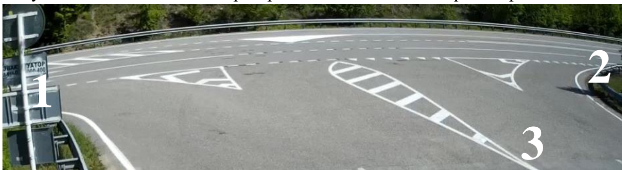
Рисунок Г.15.2 – Фото перекрестка а/д 00 ОП ФЗ М-4 ««Дон» Москва - Воронеж - Ростов-на-Дону - Краснодар - Новороссийск» - Подъезд к КС «Береговая»
