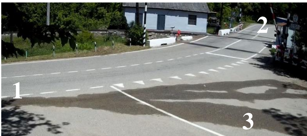
Рисунок Г.8.2 – Фото перекрестка а/д 03 ОП РЗ 03К-003 «г. Майкоп - г. Туапсе» - ул. Центральная, х. Шубинка
