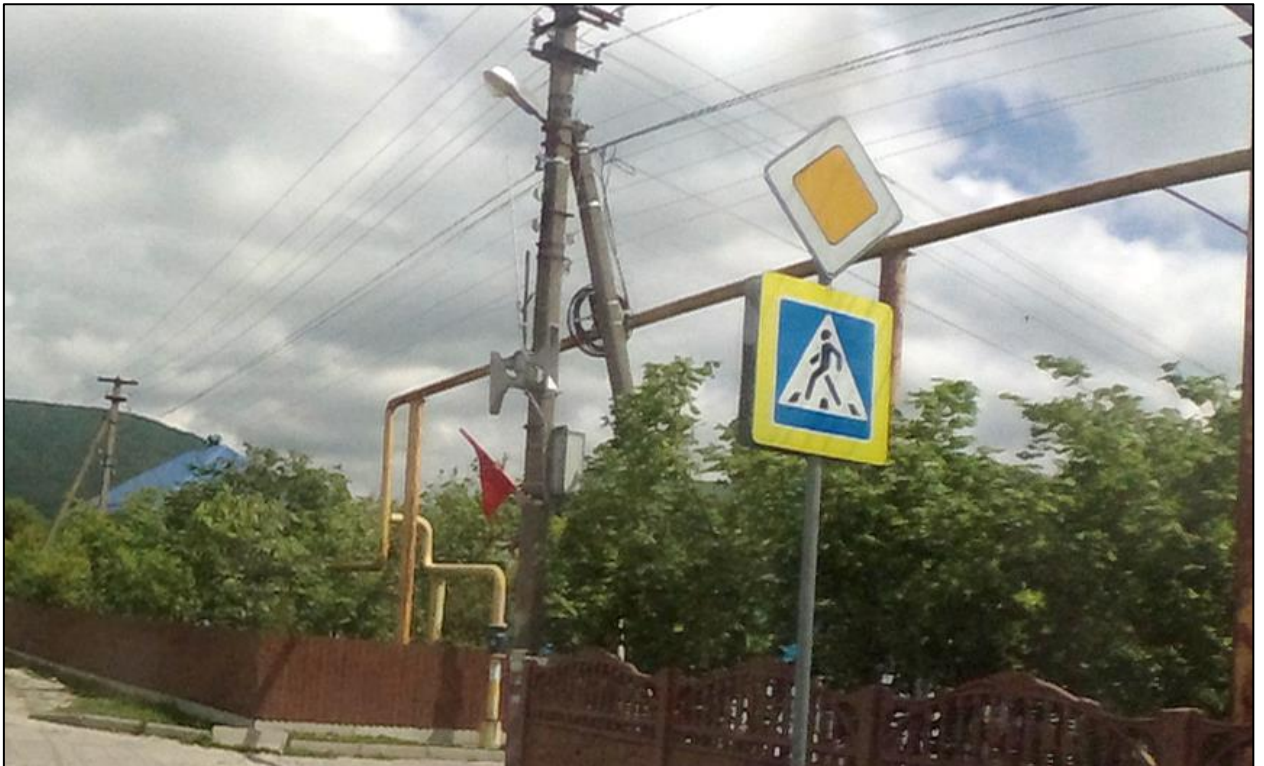
Рисунок 1.7.4 – Вид эксплуатационного состояния знака 2.1 «Главная дорога» и знака 5.19.1 «Пешеходный переход» на желтом фоне расположенных по ул. Шапсугская в а. Агуй-Шапсуг
