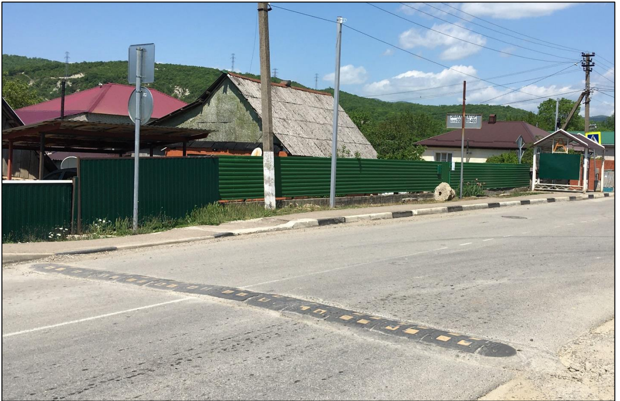
Рисунок 1.7.11 – Пример эксплуатационного состояния ИН сборно-разборной конструкции, расположенной по ул. Колхозная, п. Джубга
