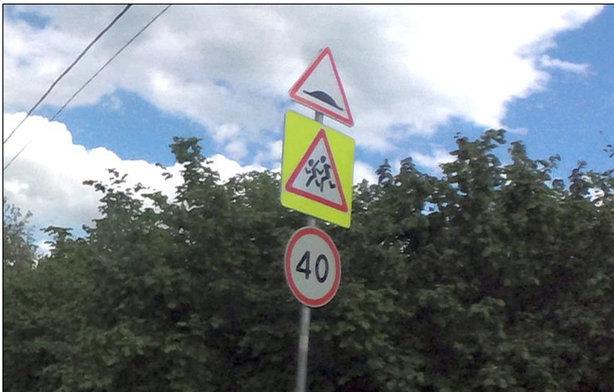
Рисунок 1.7.3 – Вид эксплуатационного состояния знака 1.17 «Искусственная неровность», знака 1.23 «Дети» на желтом фоне и знака 3.24 «Ограничение максимальной скорости» расположенных по ул. Центральная в с. Дефановка
