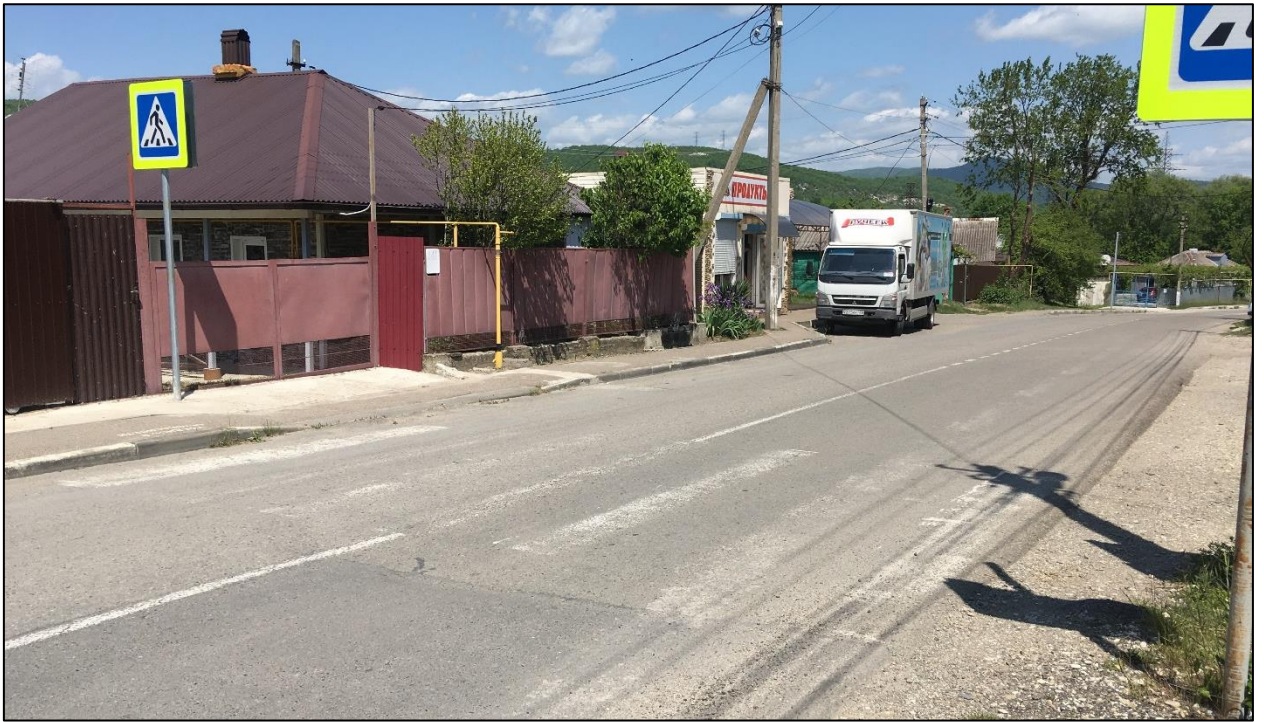
Рисунок 1.7.7 – Пример неудовлетворительного состояния разметки 1.1 и разметки 1.14.1 нанесённых по ул. Советская в п. Дzubга
