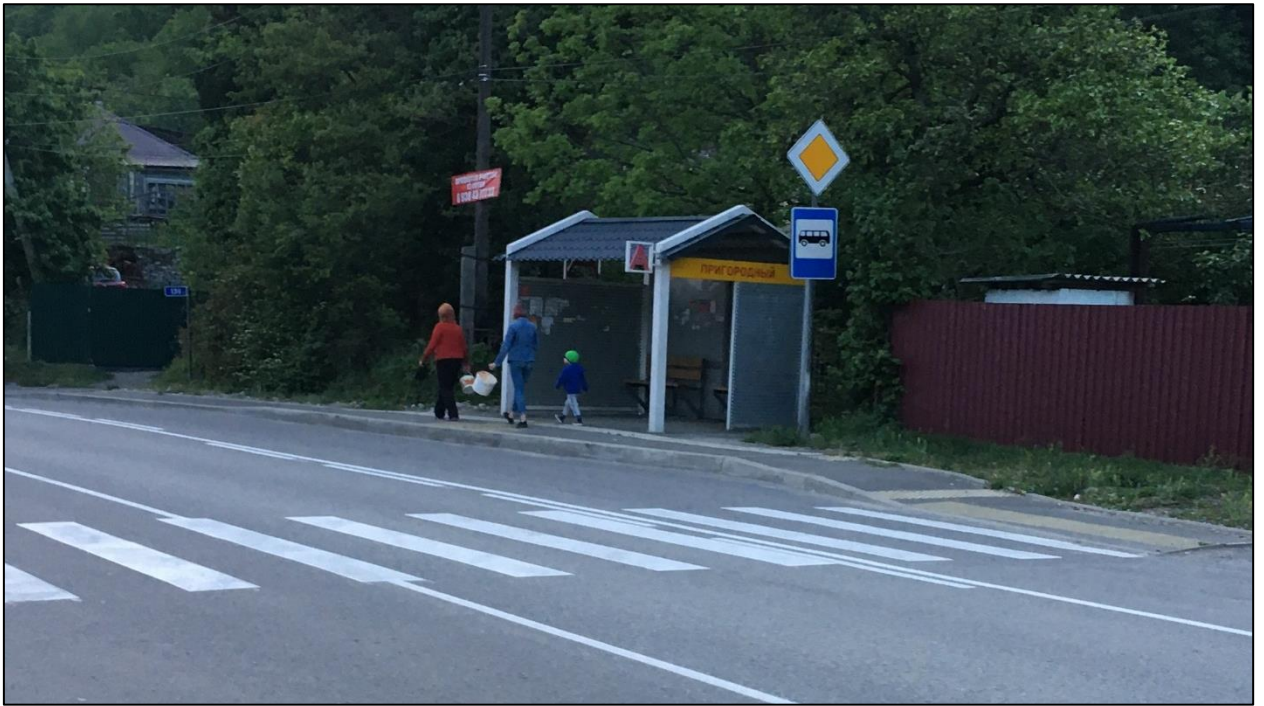
Рисунок 1.7.5 – Пример эксплуатационного состояния горизонтальной разметки 1.1 (разделяющей транспортные потоки противоположных направлений) и разметки 1.14.1 (обозначающей пешеходный переход) нанесённых по ул. Майкопская в п. Пригородный
