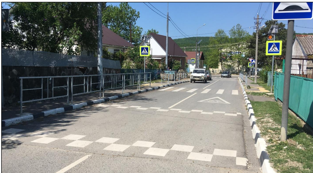
Рисунок 1.7.8 – Пример эксплуатационного состояния ИН неровности монолитной конструкции, расположенных по пер. Школьный в с. Тенгинка
