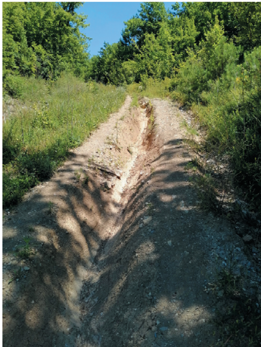
Рис. 64 Эрозионная борозда, развивающаяся по колее лесной дороги в верховьях щели Черкесская (слева, Фото Антонов О.М.), сети лесных дорог на водоразделе щелей Черкесская и Хропакова (справа, Фото БПЛА).
