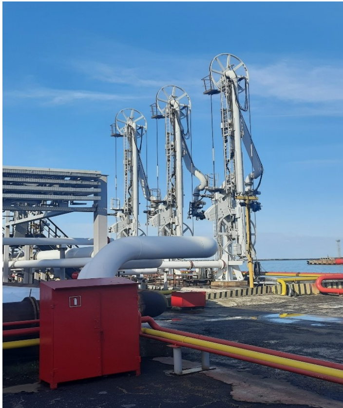
Рисунок 10– Стендеры причала №2
