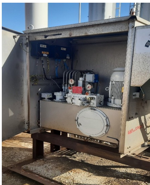
Рисунок 7 – Маслостанция причала №1
