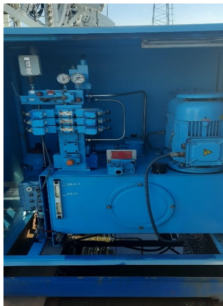
Рисунок 8 – Маслостанция причала №2
