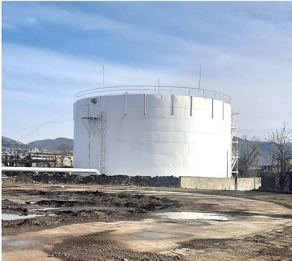
Рисунок 2 – Резервуар вертикальный стальной (РВС) № 4
