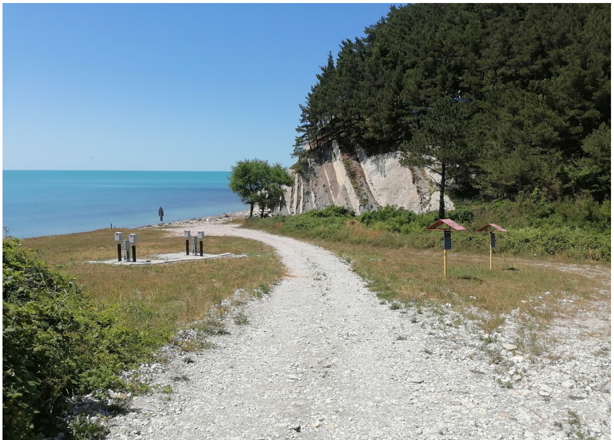
Рис. 62 Место выхода газопровода "Голубой поток" к берегу Черного моря.
